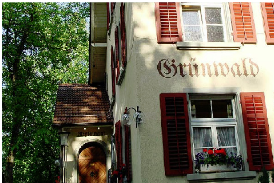
Türraum als angebautes Häuschen für sich, Grünwald, Regensdorferstr. 237, 8049 Zürich
