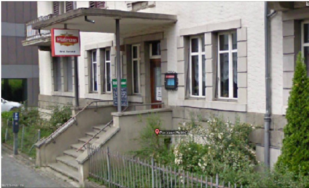
Aufgangstreppe, Farbhof, Badenerstr. 753, 8048 Zürich
