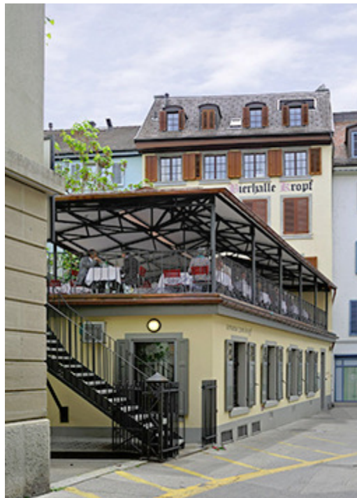
Gedeckte Terrasse auf dem Dach eines Nebengebäudes, Kropf, In Gassen 16, 8001 Zürich
