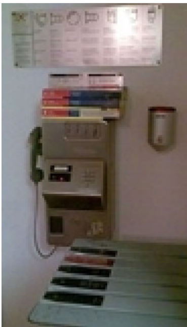
Der Telefonraum ist eigener enger Raum als Teil des Ganges.
