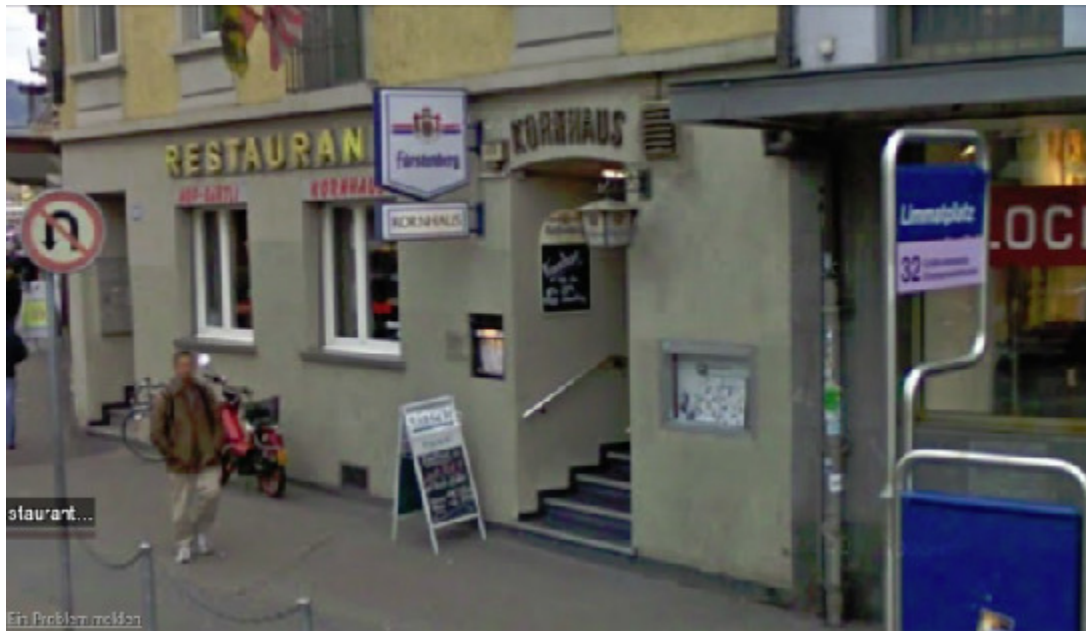
Ins Haus versetzte Treppe und Tür, Kornhaus, Langstr. 243, 8005 Zürich
